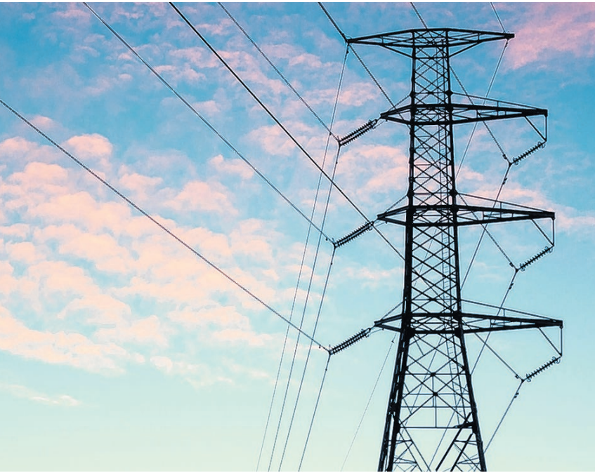
Das EW Höfe bietet neu einen Wahltarif für die Netzkosten: Er ist für Kundinnen und Kunden, die ihren Stromverbrauch mithilfe eines Energiemanagementsystems (EMS) flexibel steuern möchten.
